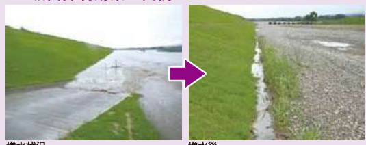
増水状況 増水後
