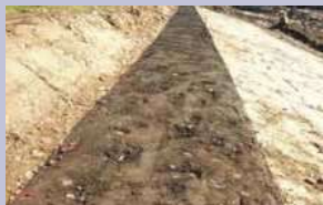
グリッドネット敷込(堤脚部・天端部・増止部)
