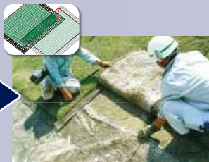
グリットシーバー敷設
