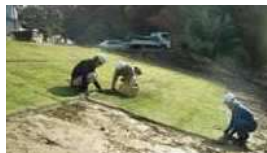
人力施工状況
