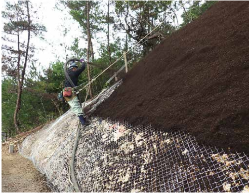
植生基材吹付工
