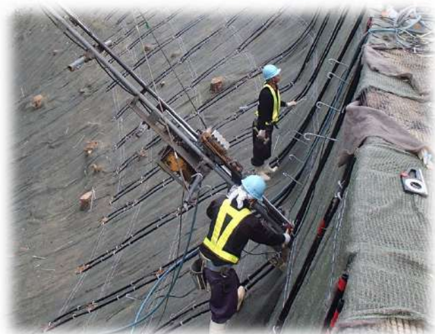
ソイルネイル挿入状況
