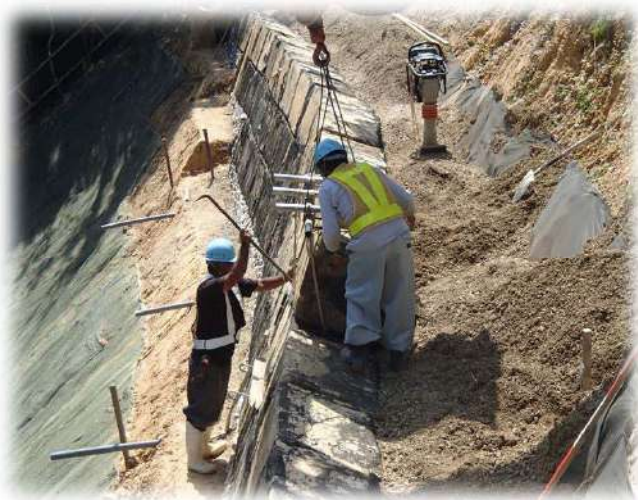
圧縮土のうを使った盛土状況
