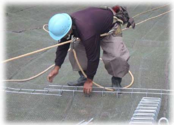
ベルトフレーム設置
