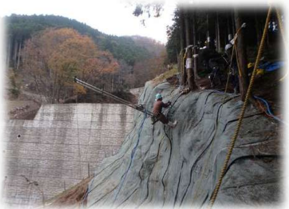
ソイルネイル挿入 ウインチ使用
