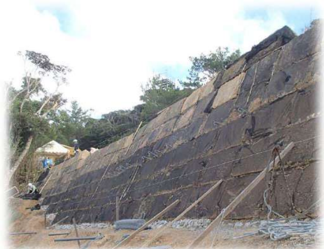
圧縮土のう積による仮土留め
