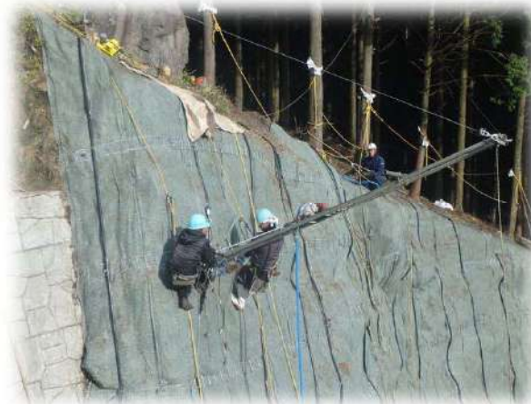
ウインチ使用人力施工
