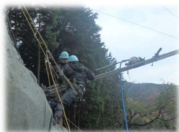
ソイルネイル挿入 ウインチ使用
