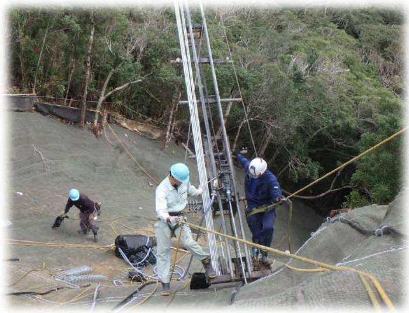
ソイルネイル挿入
