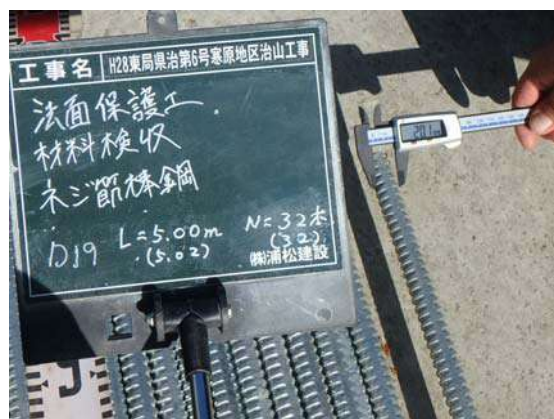
ソイルネイル D19mm 溶融亜鉛メッキ加工
