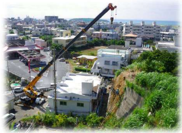
25tクレーン使用
