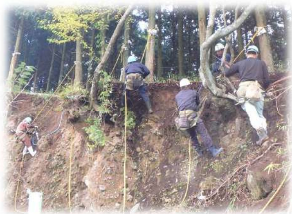
人力法面整形 オーバーハング除去
