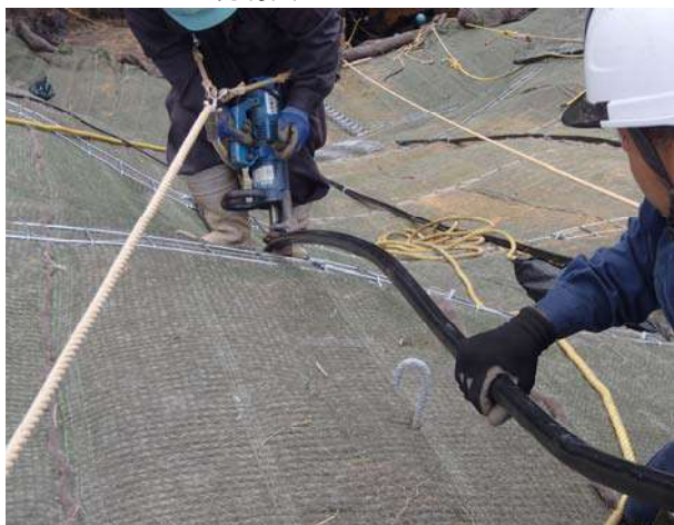
ホールディングバー設置状況 現場曲げ加工
