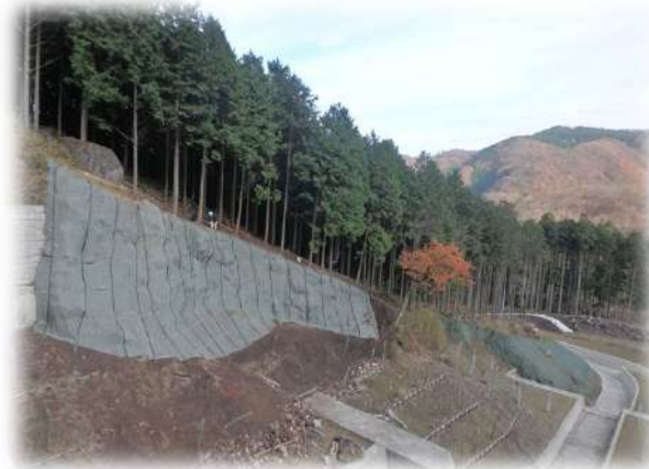
人力による法面保護工完成
