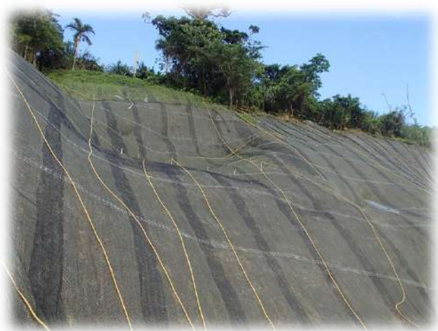
高強度植生マット、ベルトフレーム設置
