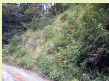
施工後5年3ヶ月
