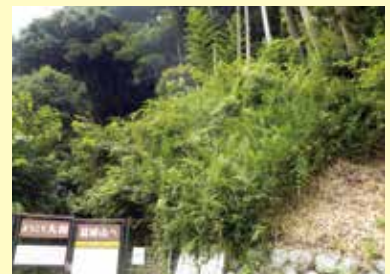
施工後 3 年 5 ヶ月
