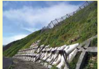
施工後 5 年 8 ヶ月
