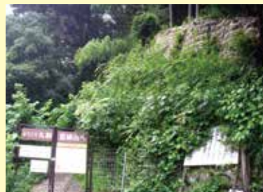
施工後 1 年 4 ヶ月
