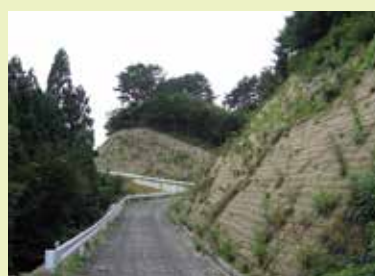
施工後 1 年 1 ヶ月
