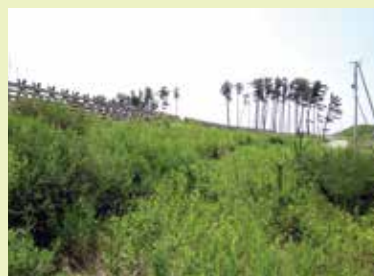
施工後3年4ヶ月
