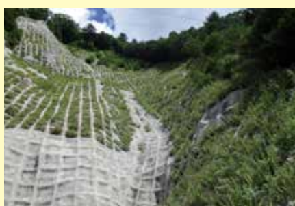
施工後 3 年 1 ヶ月
