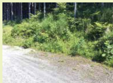
施工後2年5ヶ月
