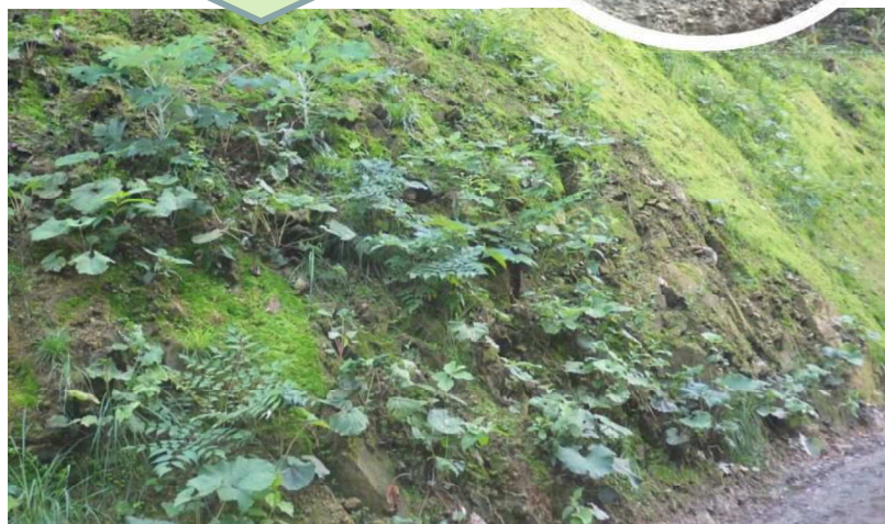
BSC工法適用個所の例 ※侵入した植物・コケ等が生育
