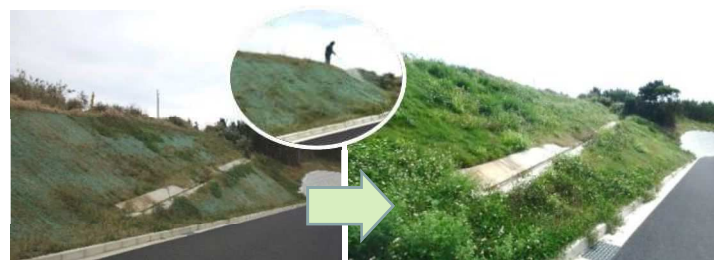
植生生育不良の植生シート工の上から施工して、検査に合格する十分な植生形成を行った例
