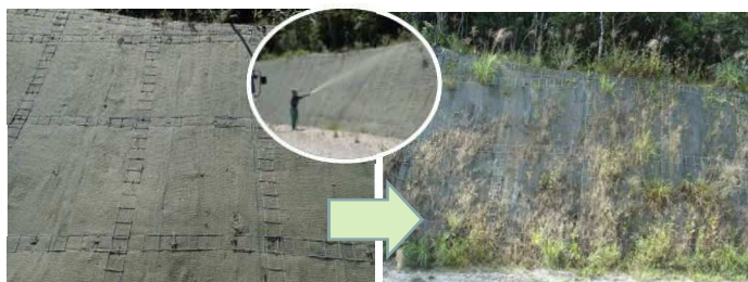
施工から2年経過しても植生侵入のない従来型の自然侵入促進工に対して植生侵入を促した例
